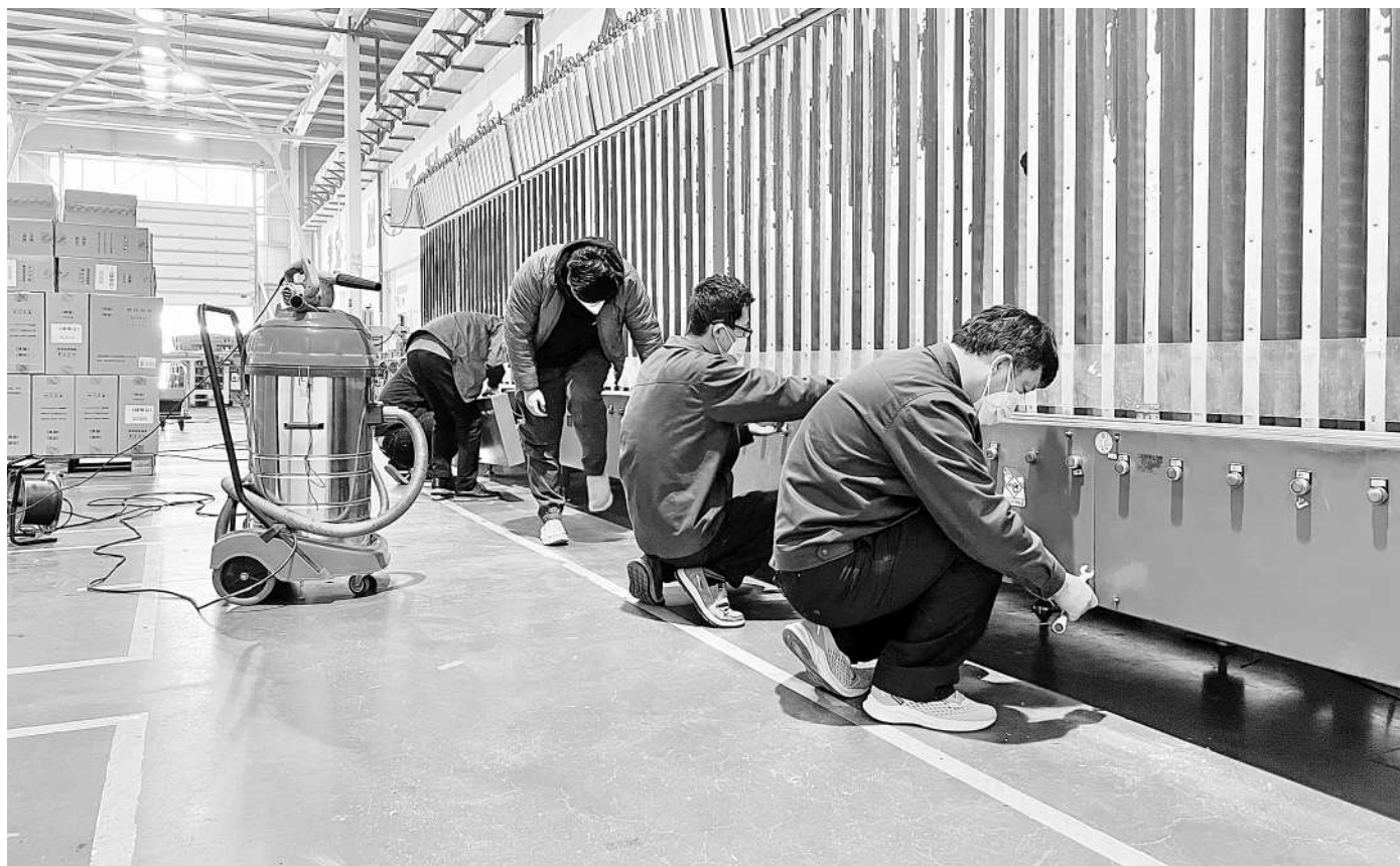
河南省郑州市烟草专卖局(公司)物流中心近期加强调度,组织人员对设备进行全面检修,排查隐患,确保设备正常运转,有效保障市场供应。图为工作人员正在对设备进行清洁检修。 孙文峰 王庆贤 摄影报道
